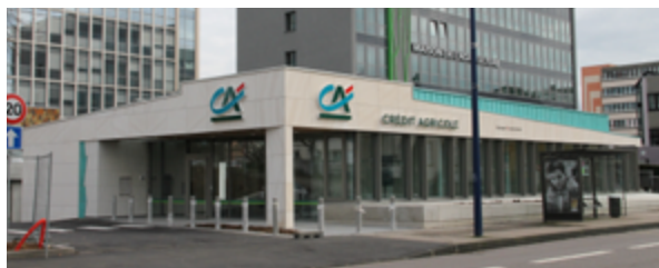
La nouvelle agence « Passivhaus » à Metz Amphithéâtre.
